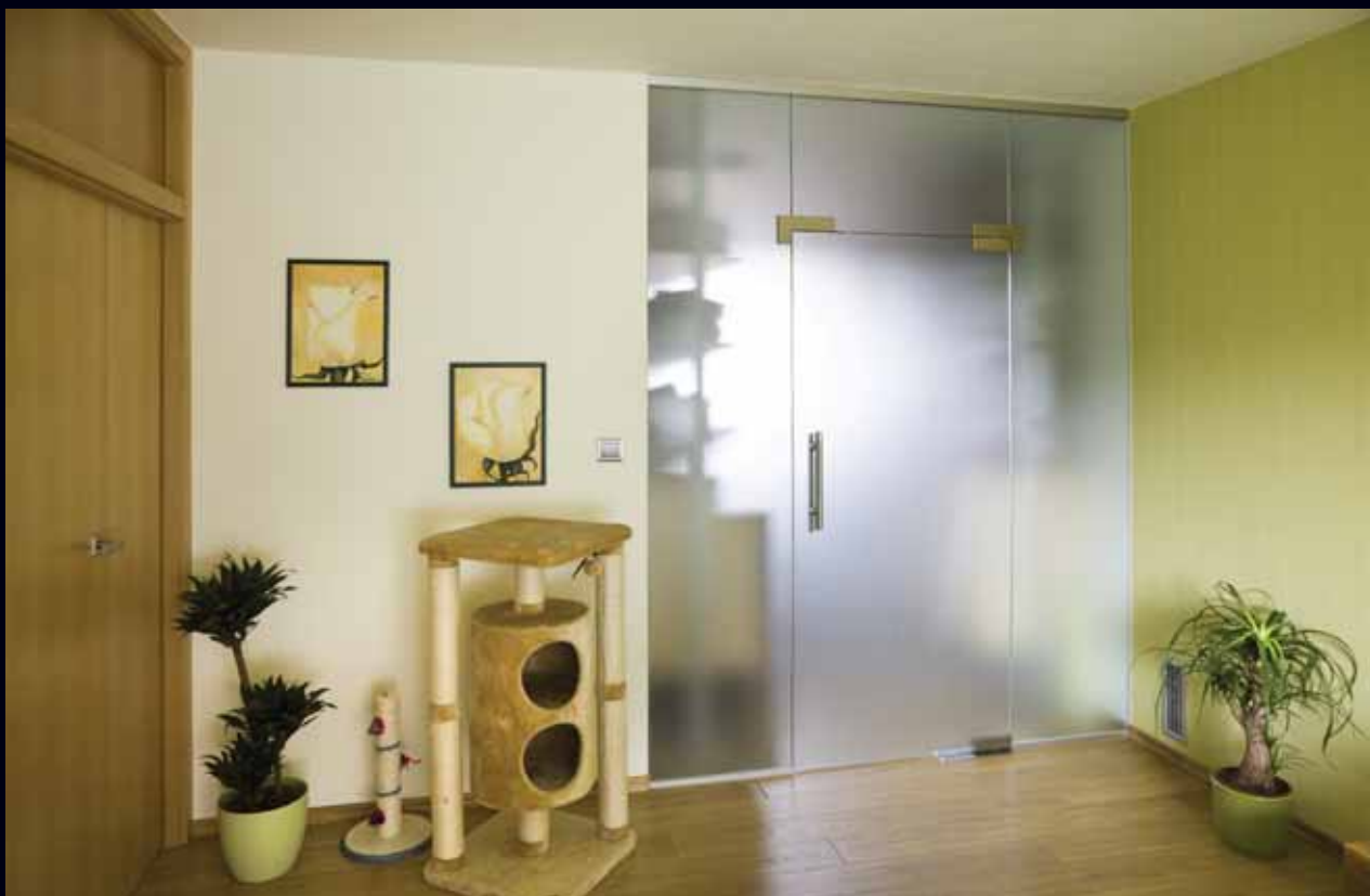
1-křídle kyvné dveře 900/2000 s 2x bočním světlíkem a nadsvětlíkem, stavební otvor: 1974/2558 (dveře uvnitř stěny), sklo: satínato bílé 10 mm kování: zavírač BTS 75 V + Universal PT (matná stříbrná) + madlo IMD 01 (nerez brus/lesk)
