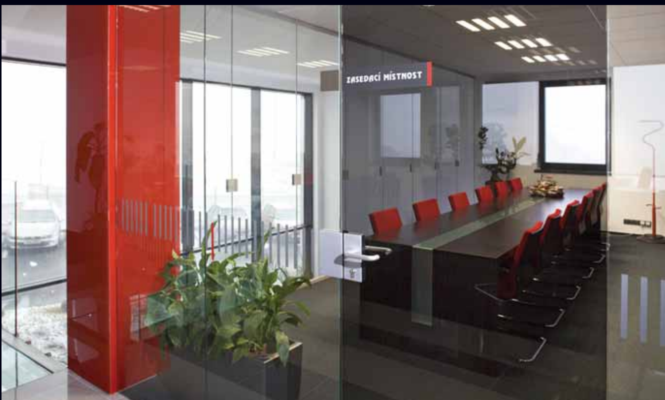
1-křídle otočné dveře 900/2200 s 3 x bočním světlíkem a nadsvětlíkem, stavební otvor: 4250/2650, sklo: dveře - planibel šedý, 10 mm, boční světlík a nadsvětlík - float čirý 10 mm kování: zavírač BTS 75 V + Universal PT + klika junior office classic s protikusem (matná stříbrná), (fixní část kotvena dole do U-profilu a nahoře do Wandanschlussprofilu)
