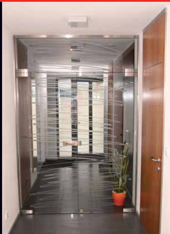
2-křídle dveře 800+800/2100 s nadsvětlikem (1-křídle otočné, 2-křídle fixní - západky), stavební otvor: 1600/2620, sklo: float čirý 10 mm, dekor: S M40 P kování: čep do podlahy + Arcos Universal PT + klíka AR 01/107 s protikusem (elox nerez brus)
