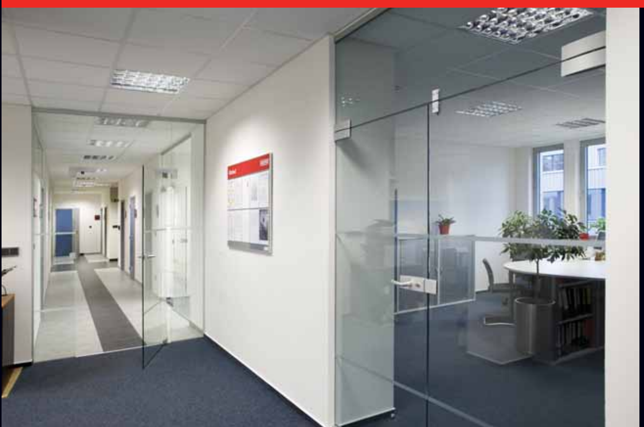
1-křídlé otočné dveře 970/1970 s 2x bočním světlíkem a nadsvětlíkem, stavební otvor: 1770/2620 (dveře uvnitř stěny), sklo: float čistý 10 mm, výstražný polep kování: čep do podlahy + Arcos Universal PT + kliky AR 03/114 s protikusem (matná stříbrná) (fixní část kotvena dole do U-profilu a nahoře do Wandanschlussprofilu)
