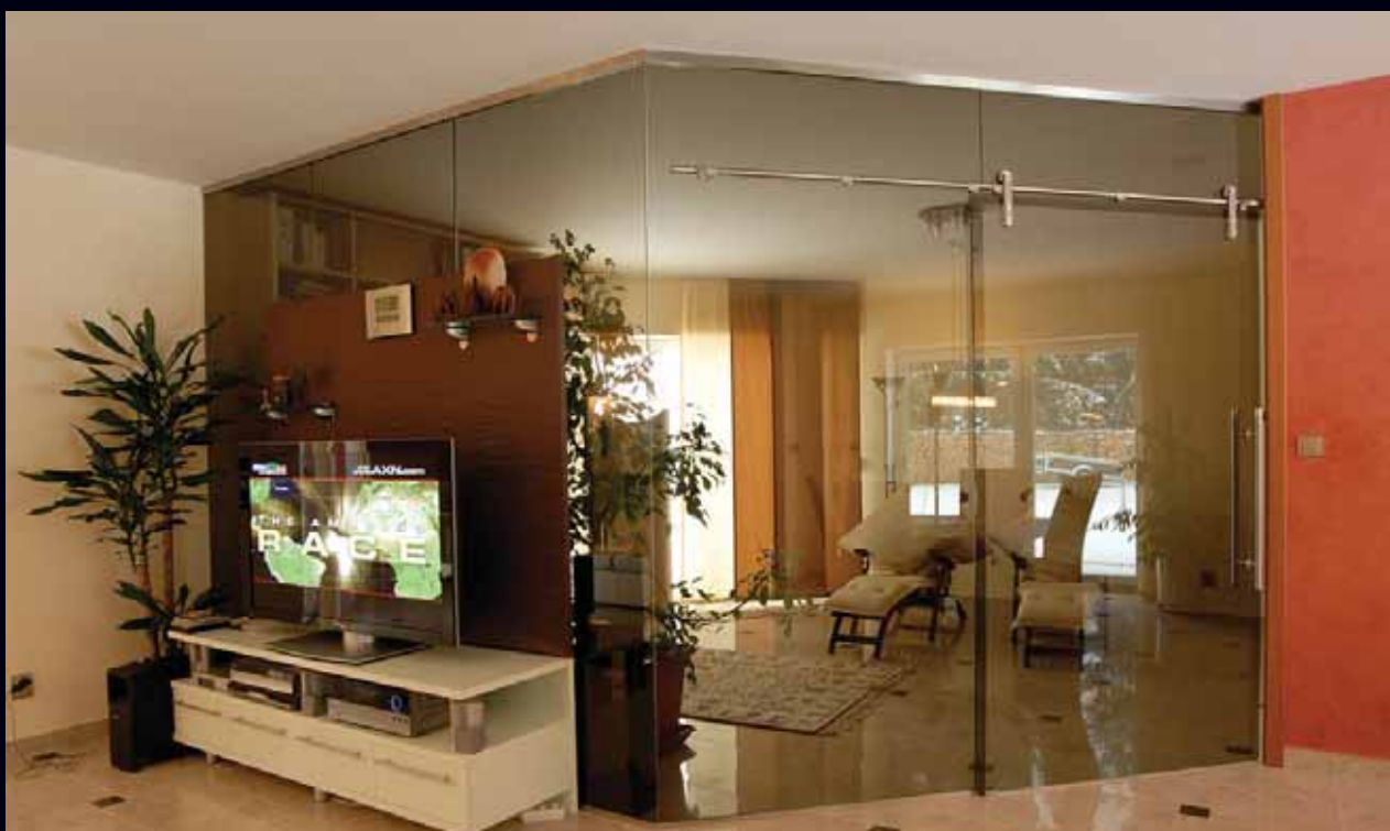
1-křídle posuvné dveře 1200/2200 s nadsvětlíkem na boční světlík + fixní stěna, stavební otvor: 2920/2670 + 2400/2670, sklo: planibel bronz 10 mm kování: Manet 5.1 (nerez brus) + madlo MD 01 atyp (nerez brus/lesk)
