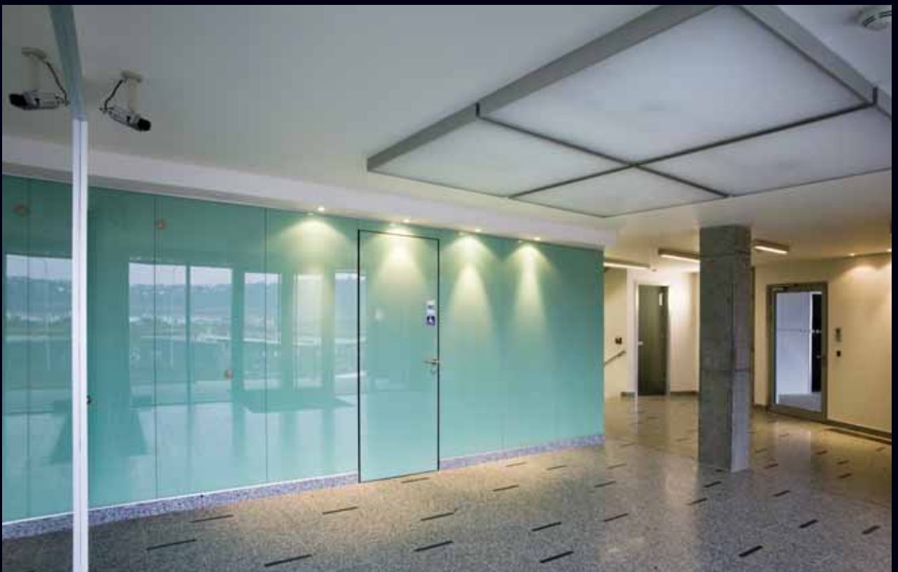
celoskleněný obklad stěny a 1 kus dveří, sklo: float čistý 5 mm + RAL tyrkys
