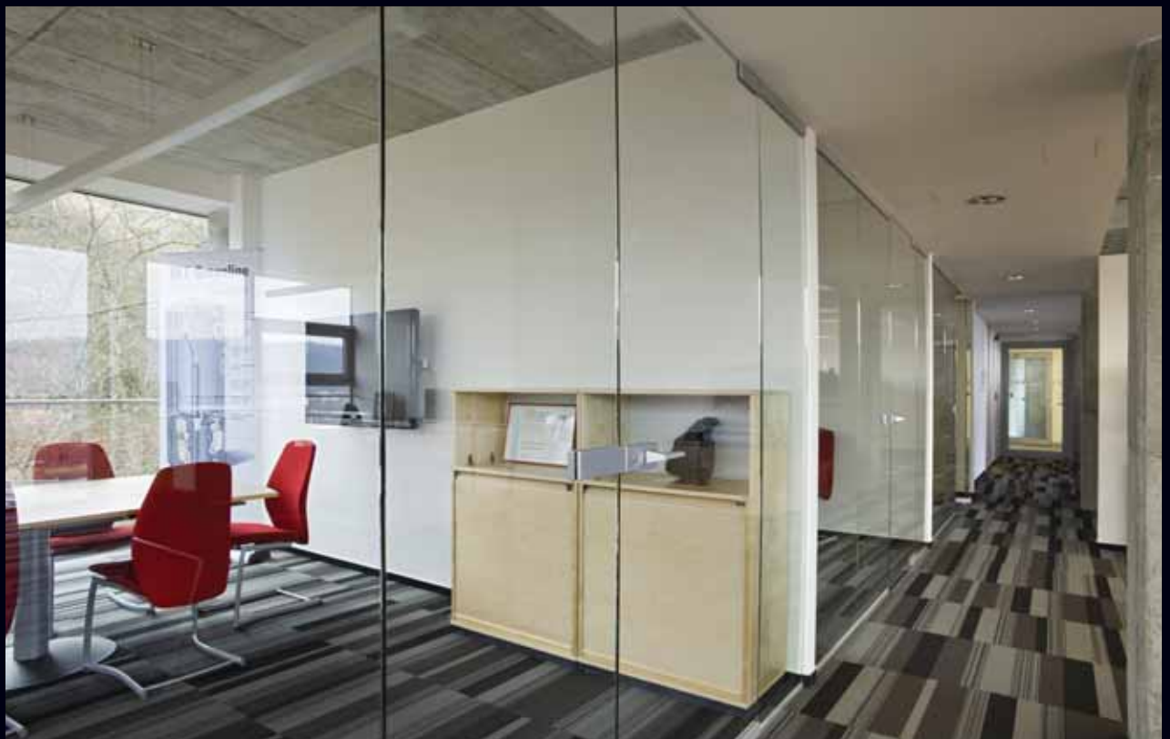
1-křídle otočné dveře 860/2350 s 3x bočním světlíkem, sklo: float čirý 10 mm, kování: čep do podlahy + Universal PT + Classic 03/101 s protikusem (matná stříbrná)
