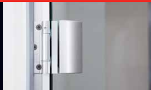
detail otevřeného pantu z rubové strany
