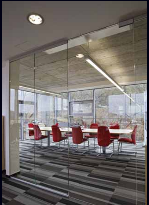
celoskleněná stěna: 1-křídlé otočné dveře 880/2350 + 3 x boční světlík sklo: float čirý 10 mm, kování: Universal PT, klika Classic 03/101
