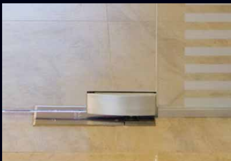
detail spodního pantu s podlahovým zavíračem
