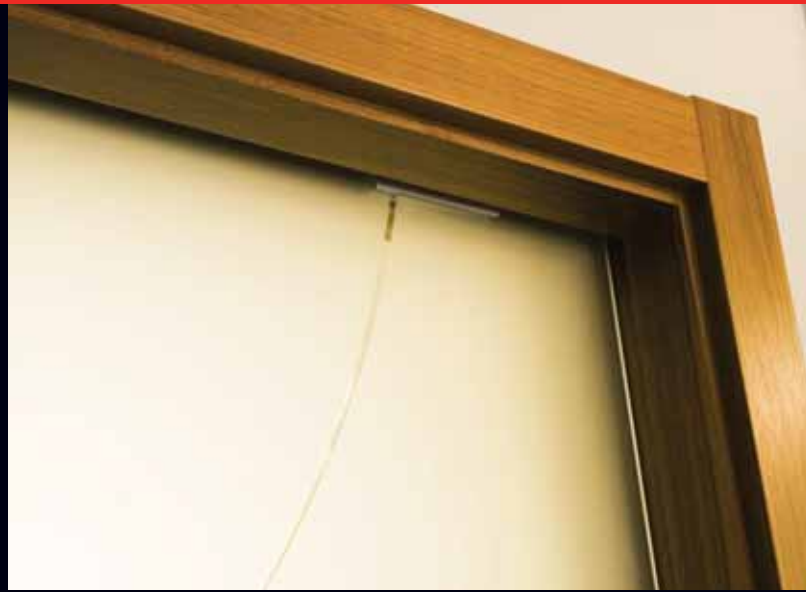
detail horního okraje skla s vozíkem
