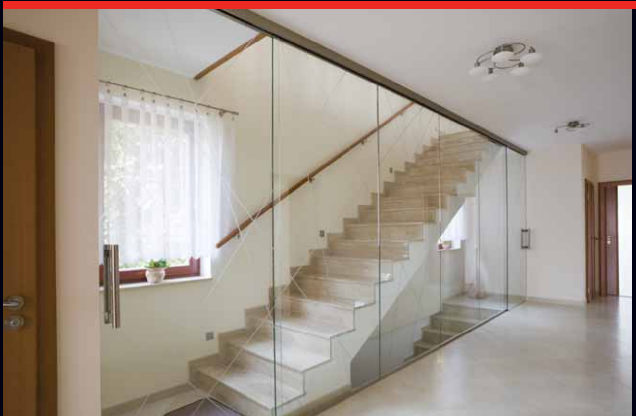
2 x 1-křídle posuvné dveře 1000/2600 mm na boční světlík (sloužící jako zábradlí), stavební otvor: 6500/2600 mm, křídla – float čirý 10 mm + atypické pískování boční světlík – connex čirý 6.6.2 ESG + atypické pískování, kování: Agile 150 (nerez brus) + madlo MD 02 (nerez brus/lesk)
